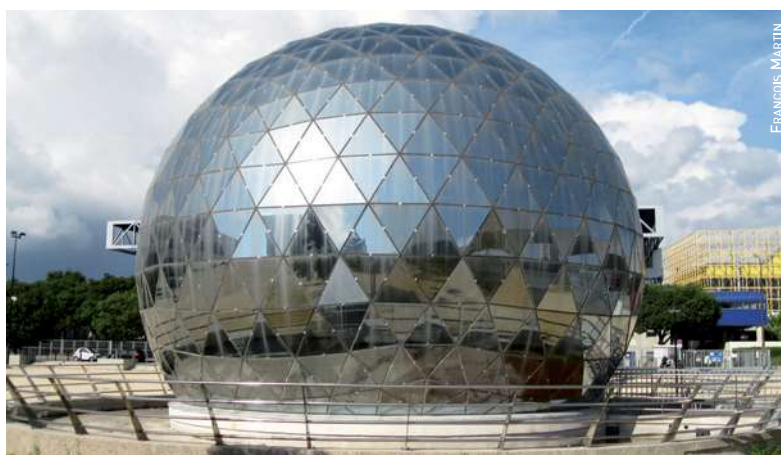
Vue extérieure de la station Géolide
