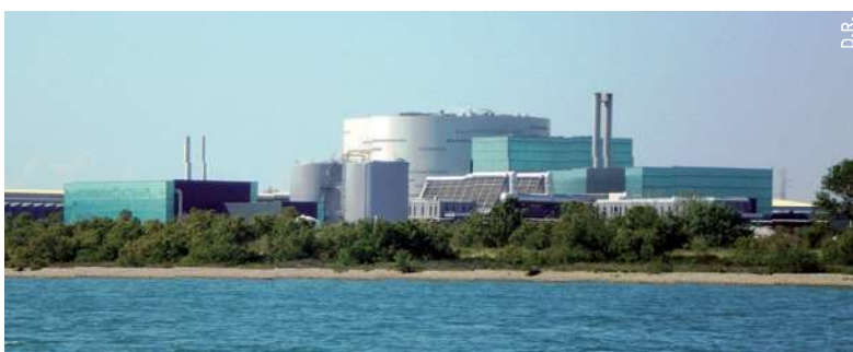
Vue du centre de traitement multifilière de déchets ménagers, EveRé
