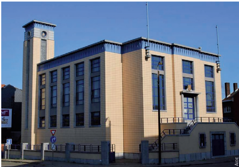
Station de pompage principale n°6 de Seraing
